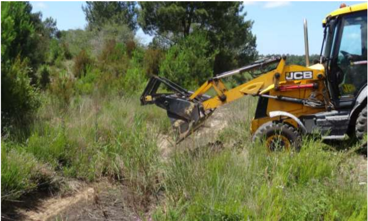
Travaux de suppression de drainage- Juin 2018 – Crédit photo SIAEBVELG
