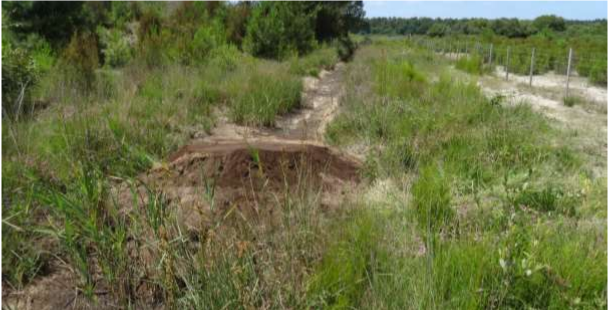
Travaux de suppression de drainage- Juin 2018 – Crédit photo SIAEBVELG
