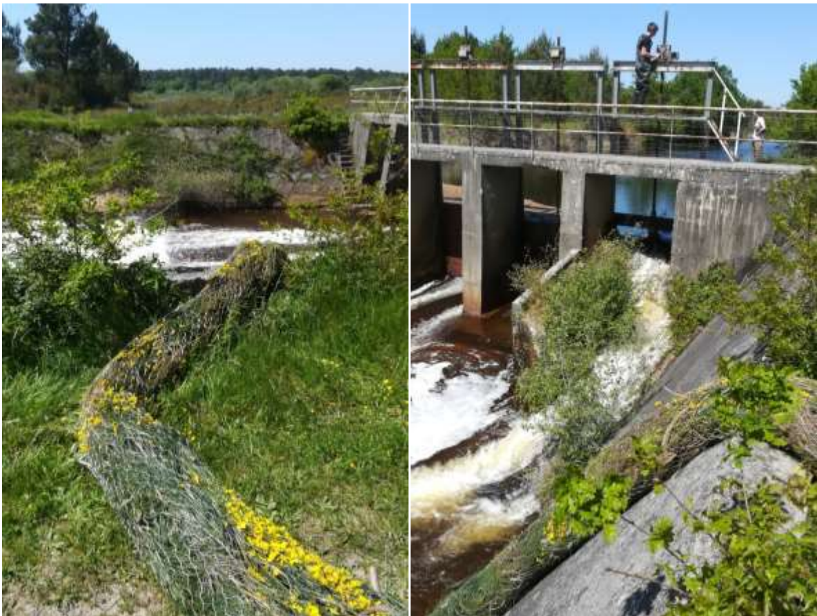
« Boudins de genêt » pour équipement passe à civelles- Mai 2018 – Crédit photo SIAEBVELG
