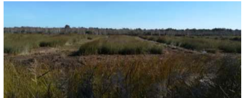
Travaux sur marais du Gnac – Octobre 2018 – Crédit photo SIAEBVELG
