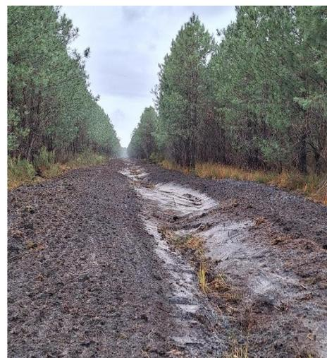
*Travaux d'optimisation du réseau de drainage à Sescousse sur 3 km avec reprofilage et réhaussement du lit à 40 cm*
