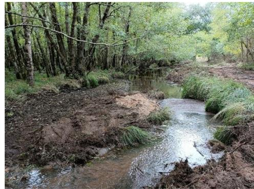
*Schéma de principe et réalisation de banquettes au sein du cours d'eau, s'appuyant sur les atterrissements existants du cours d'eau*
