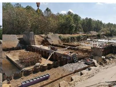
*Démolition des anciens piliers, mise en place d'une enceinte de protection en palplanches et construction des nouveaux radiers et murs : juillet - août*
