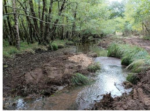
Figure 8 : Schéma de principe et réalisation de banquettes au sein du cours d'eau, s'appuyant sur les atterrissements existants du cours d'eau
