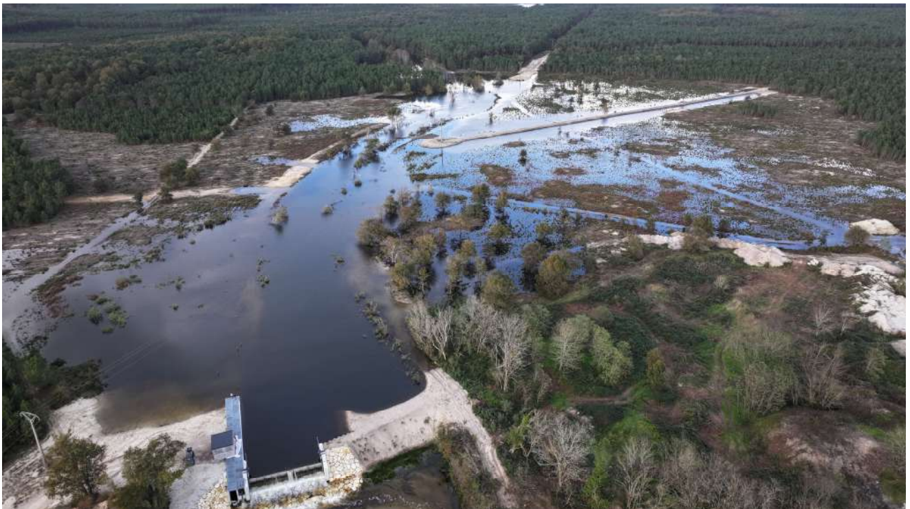
Le marais de l'Ilette remis en eau après 150 ans
