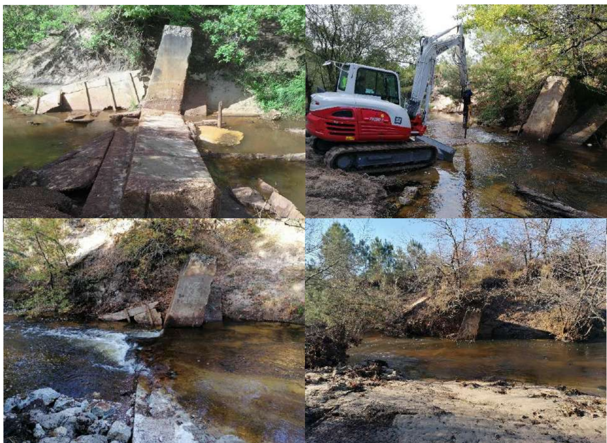
Situation avant et après travaux sur l'ancien ouvrage du Pas du Bouc
