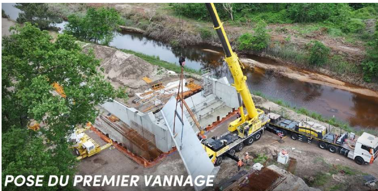
Aménagement de l'ouvrage amont pour restaurer le marais de l'Ilette février à juin 2025
