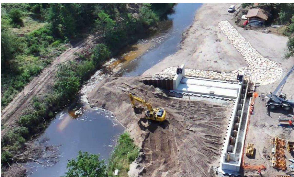
Construction d'une passe à poissons et d'une passe à anguilles en rive droite sur l'ouvrage amont - février à décembre 2025
