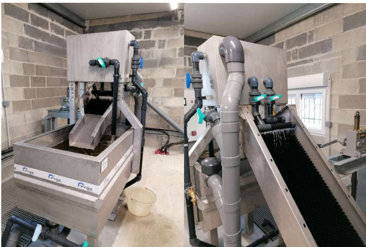
Aménagement des dispositifs de suivi des anguilles (montaison et dévalaison) - novembre 2025
