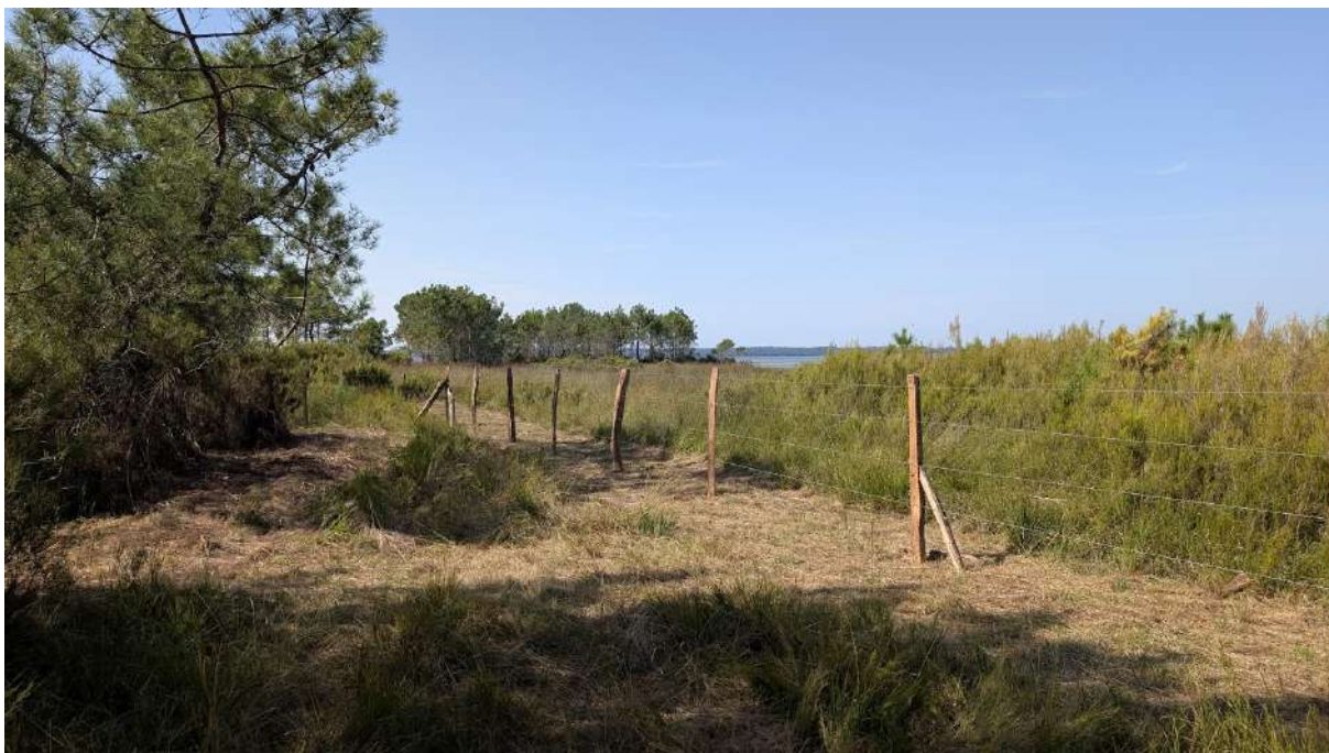
Travaux de déplacement des clôtures – Barouins, Hourtin – 2025
