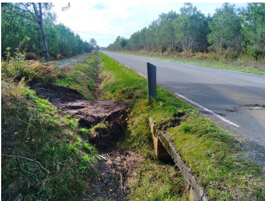
Exemple de détournement réalisé avec les services techniques de la commune
