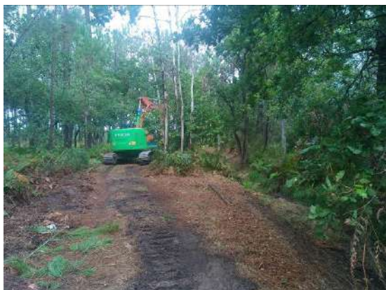
Travaux de scarification avec conservation des arbres
