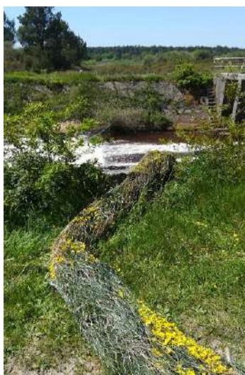
« Boudins de genêts » pour équipement passe à civelles- Mars 2025
