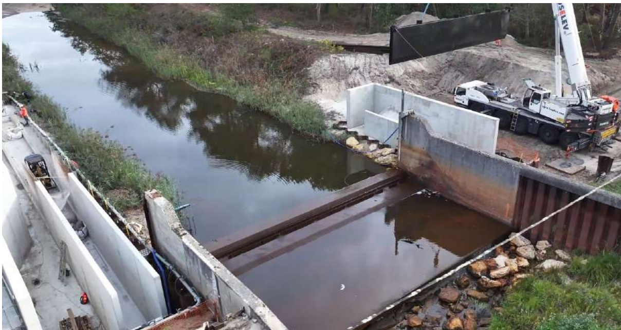
Aménagement de l'ouvrage aval : Construction d'une passe à poissons en rive droite et de deux passes à anguilles, une sur chaque rive juillet à novembre 2025
