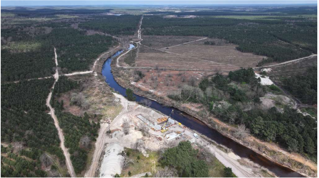
Le marais de l'Ilette pendant les travaux
