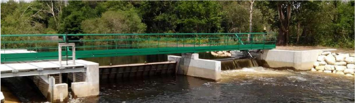
Lors des travaux, les ouvrages ont été réhaussés de quelques dizaines de centimètres afin de permettre une meilleure retenue de l'eau au printemps sur les zones humides et anticiper ainsi l'évaporation estivale qui devrait être de plus en plus importante dans le contexte de changement climatique.
